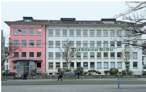
5 Gewerbehaus Badenerstrasse, Zürich
